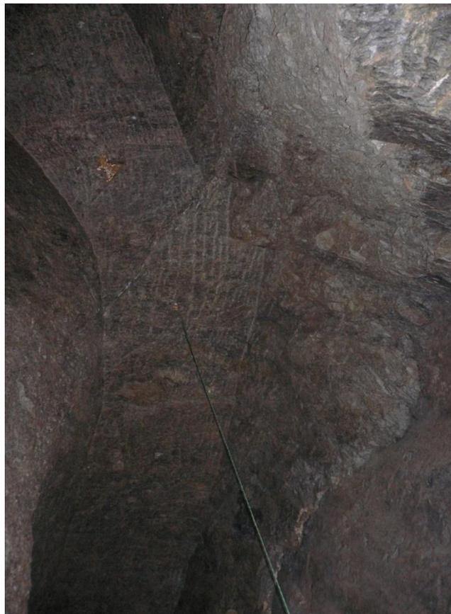
In diesem Bereich der Grube sind die Strecken ausschließlich von Hand, mit Schlägel und Eisen, vorgetrieben (Ansicht der Firste)
