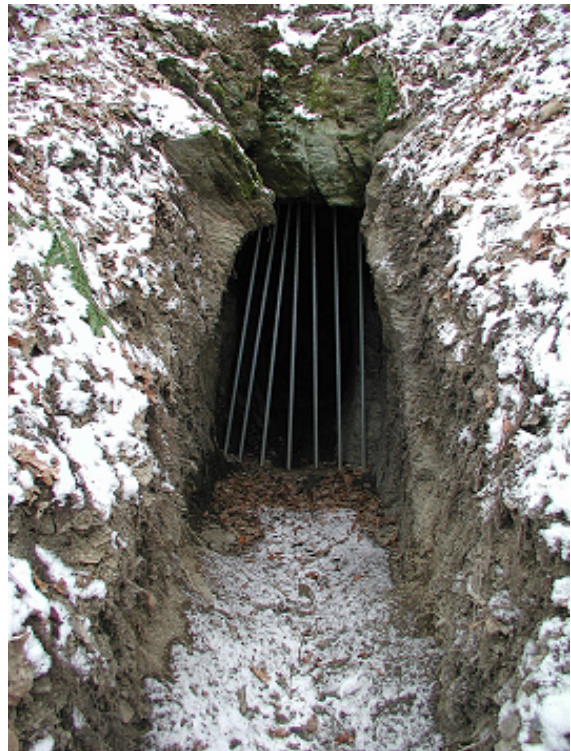
Der Stollen Wilhelm III nach Abschluss der Sicherungsmaßnahmen
