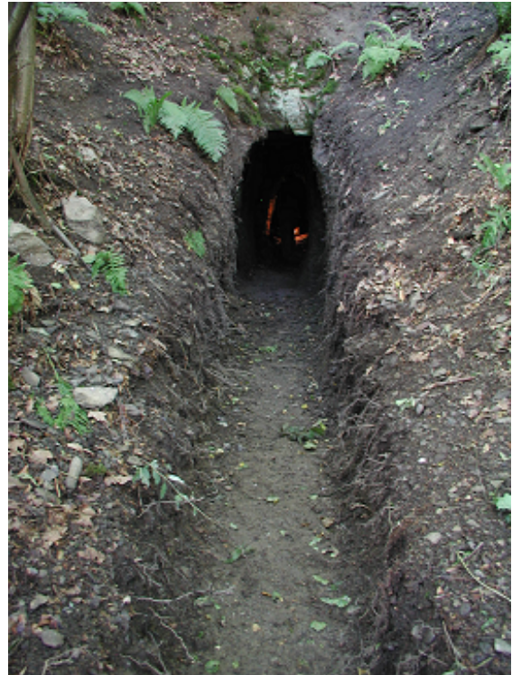
Das freigelegte Mundloch
