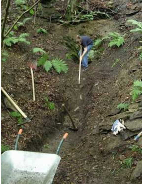
Das Freilegen des Mundloches erfolgte in reiner Handarbeit
